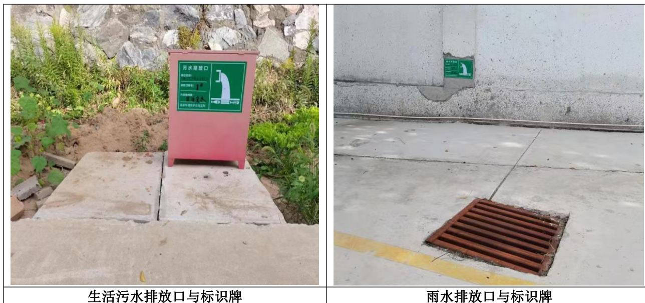
图 3-1 雨污水总排口及环保标识牌
